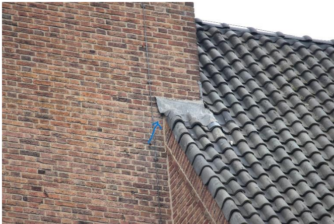
Figuur 3; invliegopening Paasbergkerk aansluiting loodslab.
